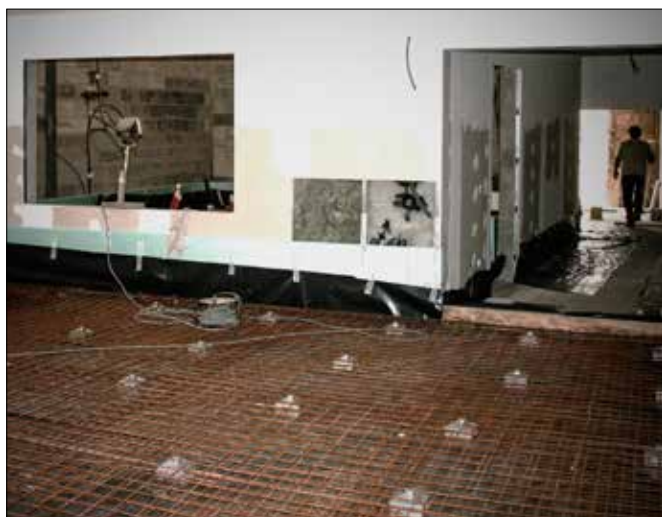
Installation du support FZH+Sylomer dans un studio de musique.
