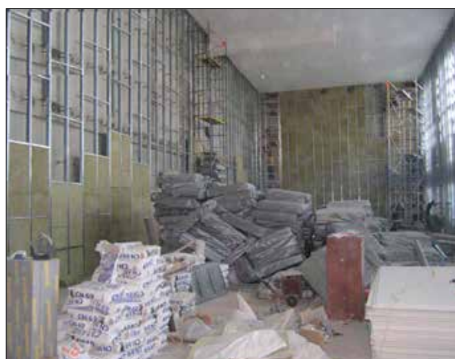
Supension des cloisons avec des EP+SYLOMER.
