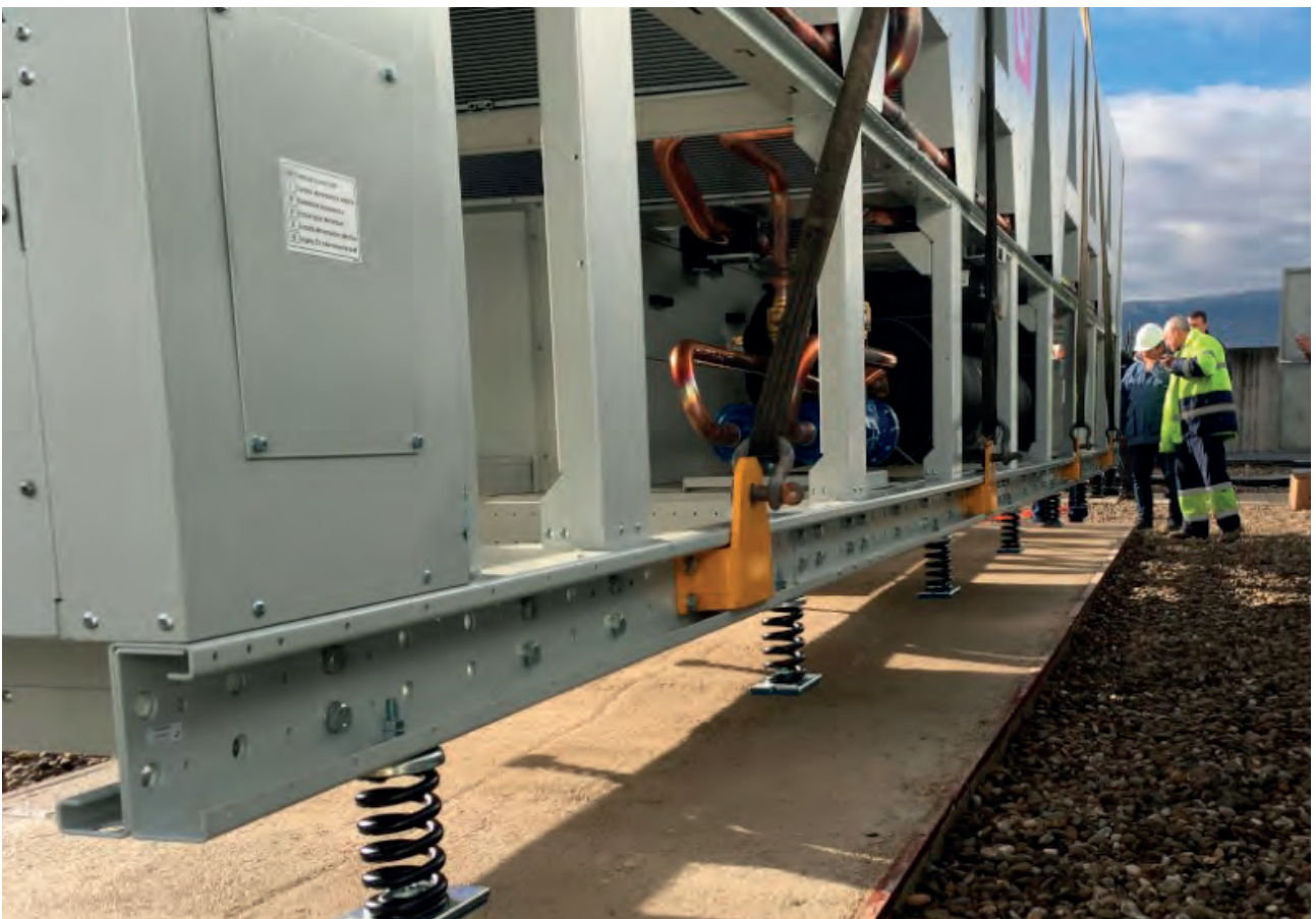
Groupe de froid isolé avec VIBRABSORBER + Sylomer®
