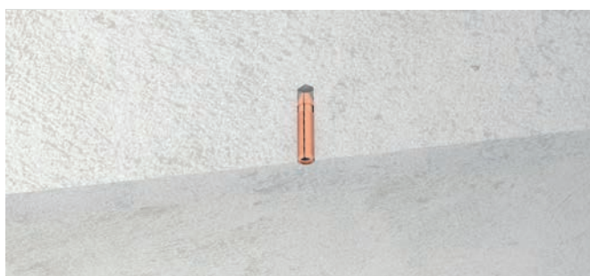
3.- Mise en place des suspentes acoustiques.
